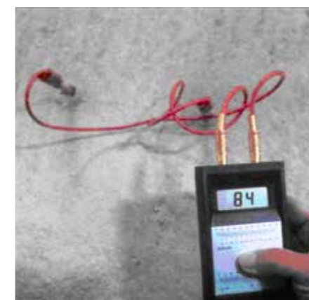
Feuchtigkeitsmessung (elektronisches System Kraft)
