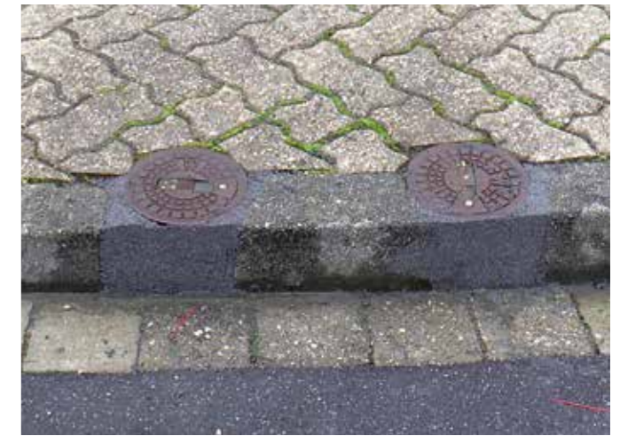
Sanierung von Bordsteinen
