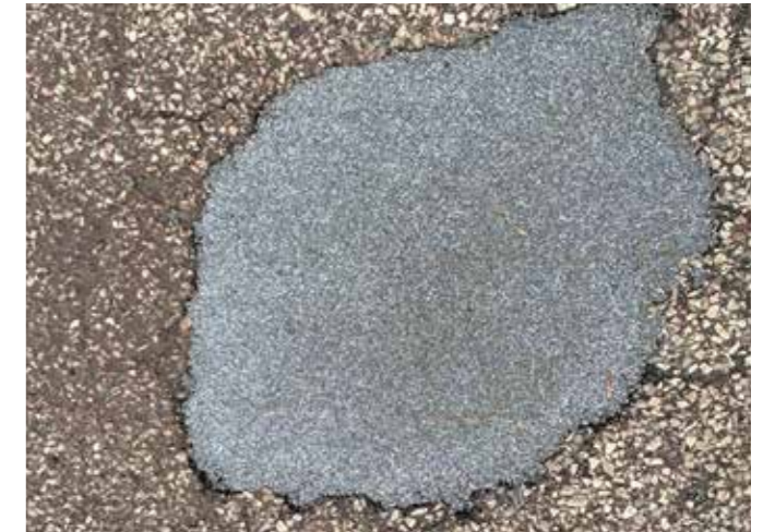
Verfüllung von Löchern und Ausbrüchen
