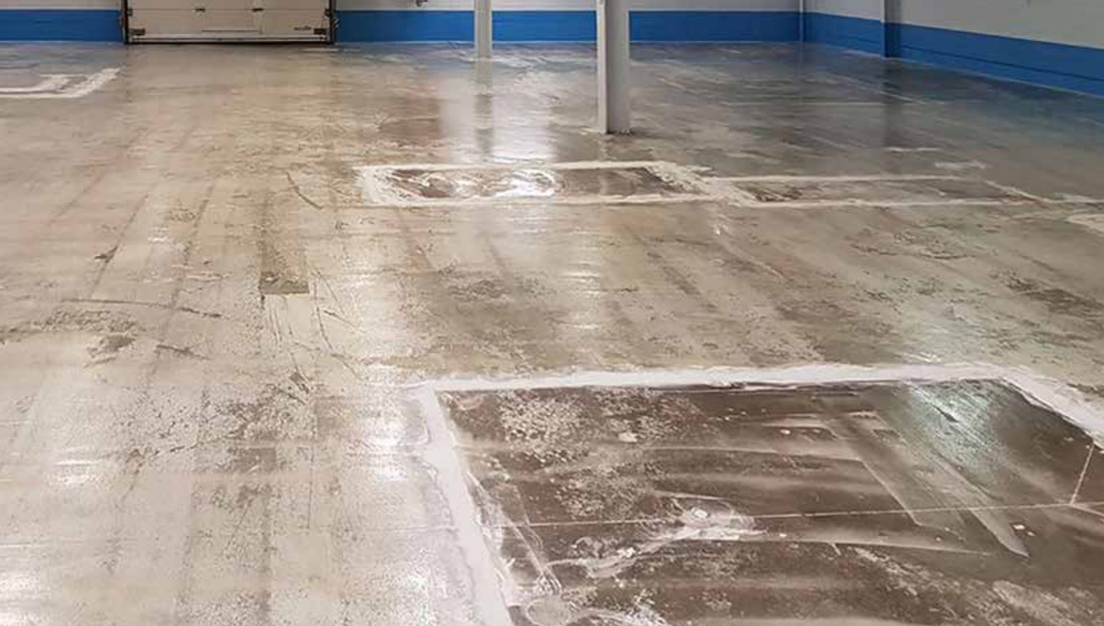
Untergrund vor der Beschichtung
