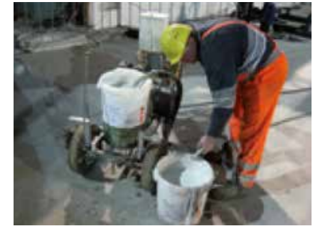
Beispiel eines Kolben-Airlessgeräts im Einsatz
