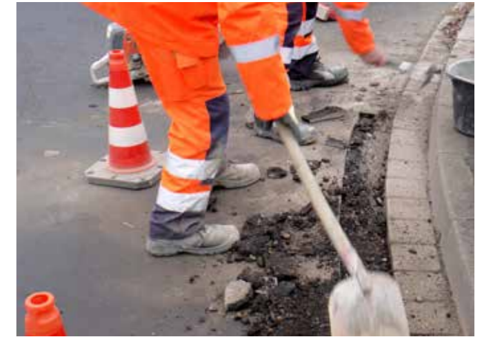
Reparatur von Straßenschäden
