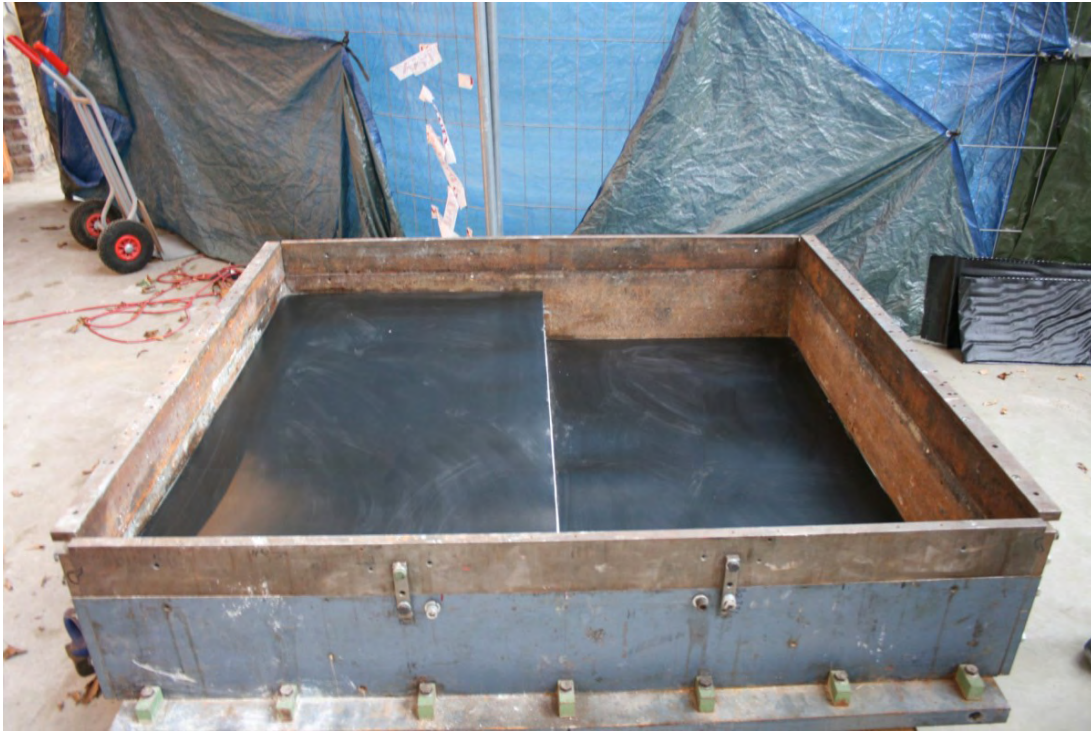
Bild 3: Einlage von Nophadrain-Schutzbahnen beidseits
