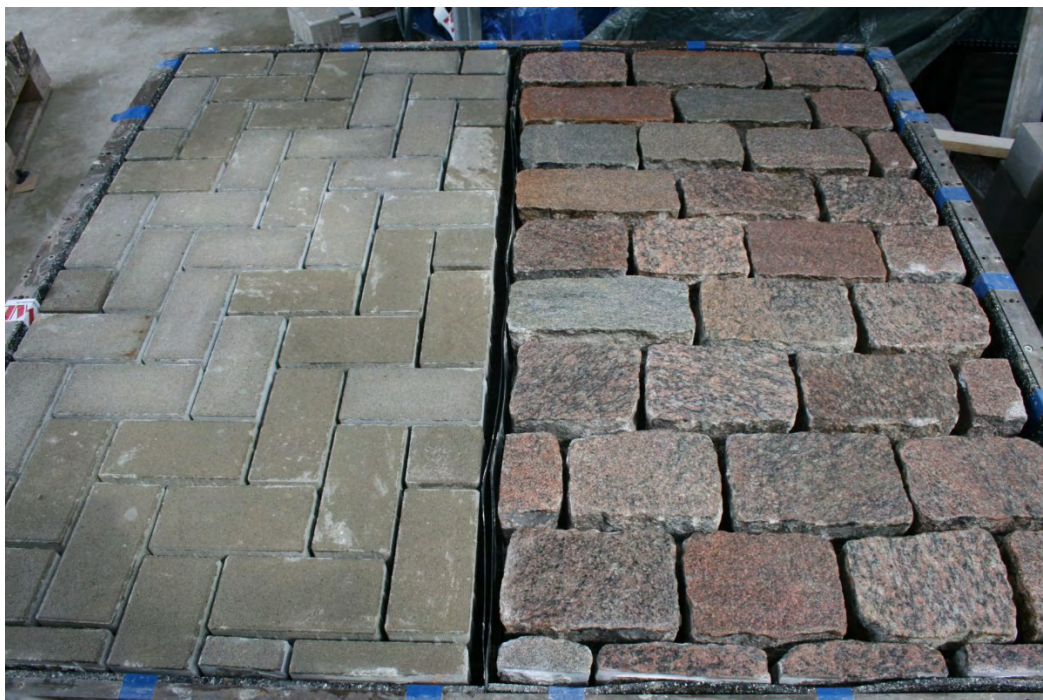
Bild 10: Abschluss der Verlegearbeiten.
