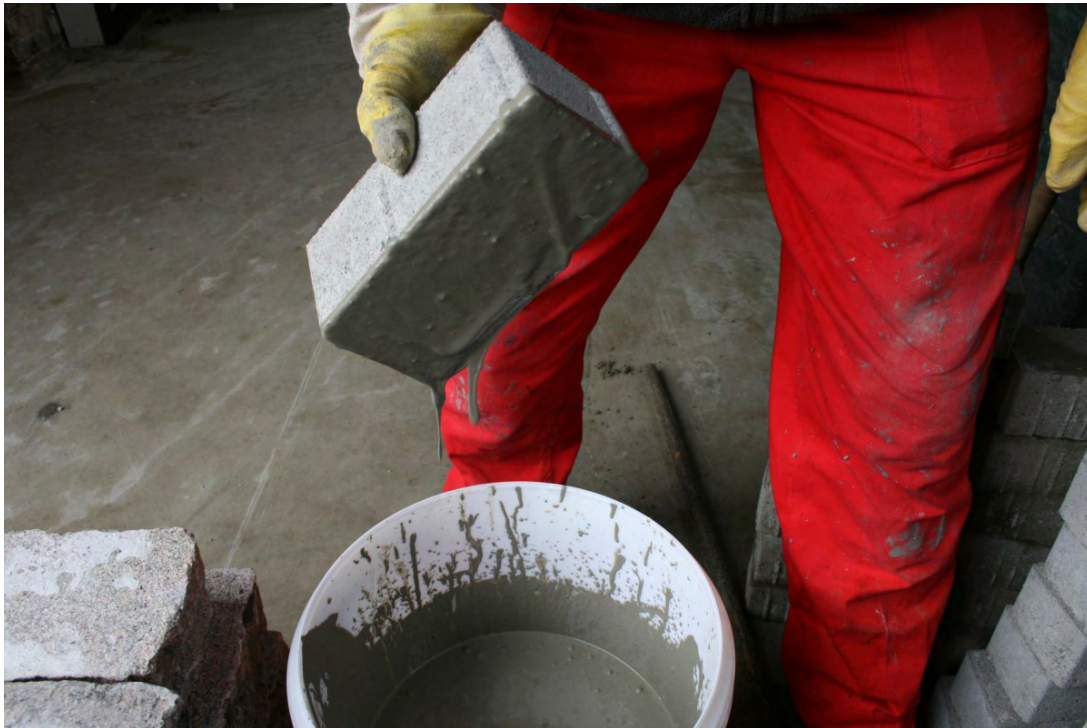
Bild 7: Vorbereitung des Betonsteinpflasters mit Auftrag der Haftbrücke (ROMEX Haftschlämme).
