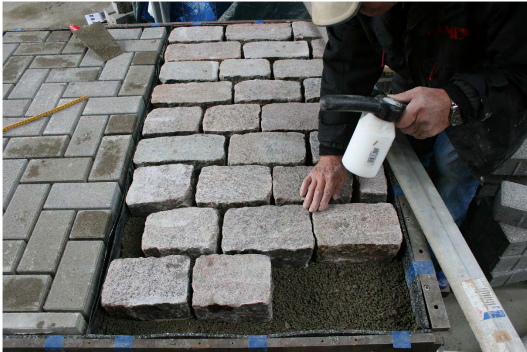
Bild 9: Verlegung Natursteinpflaster auf Bettungsmörtel (ROMEX Trass-Bettung).
