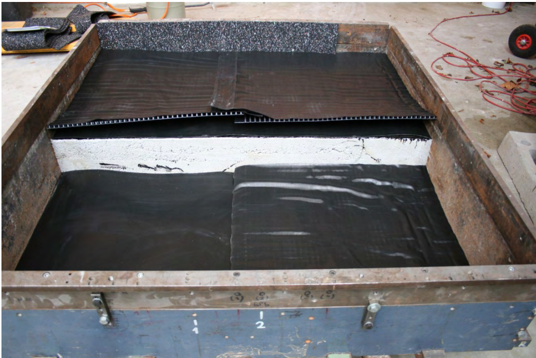
Bild 4: Auflage der Nophadrain Bahnen beidseits. Stoßfugen jeweils mittig, d.h. bei halber Überrolllänge.
