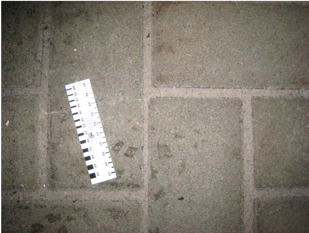
Bild 3: Detektion eines ersten Querrisses (Rissbreite 0.3mm) nach ca. 5.000 Lastwechseln der Phase 4 (50kN Radlast).
