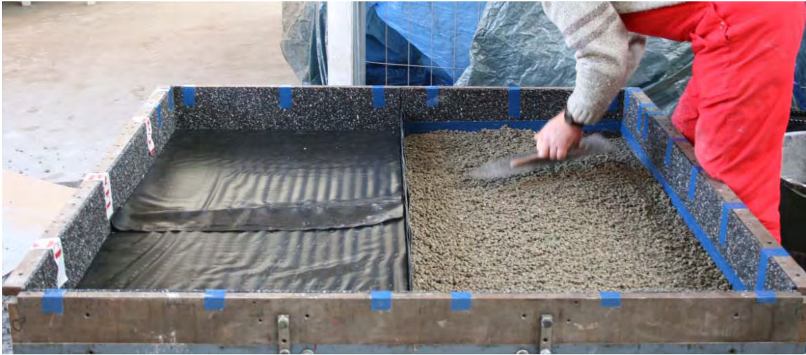
Bild 5: Einbau der Drainbetontragschicht für die Teilfläche „Natursteinpflaster“. Die Teilflächen werden vertikal durch zwei Schutzbahnlagen getrennt.
