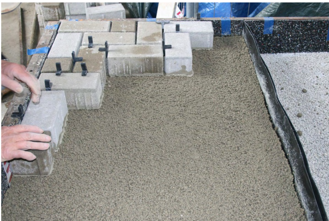
Bild 8: Verlegen des Betonsteinpflasters auf die Bettungsschicht (ROMEX Trass-Bettung).
