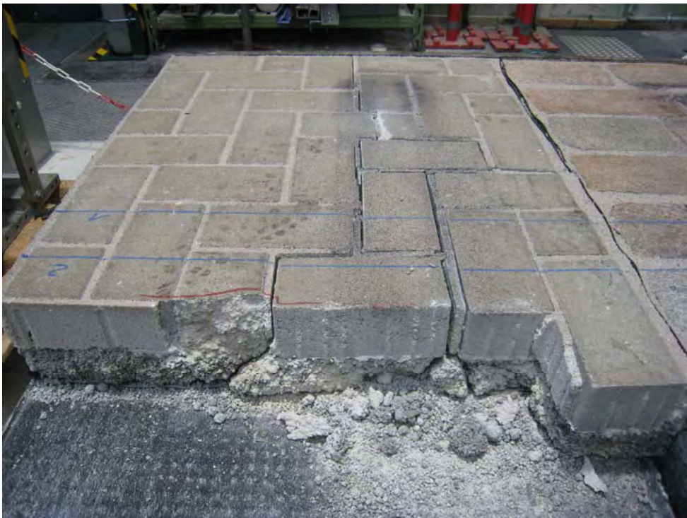
Bild 12: Verlauf sekundärer Längs- und Querrisse im Bereich der Rollspur.
