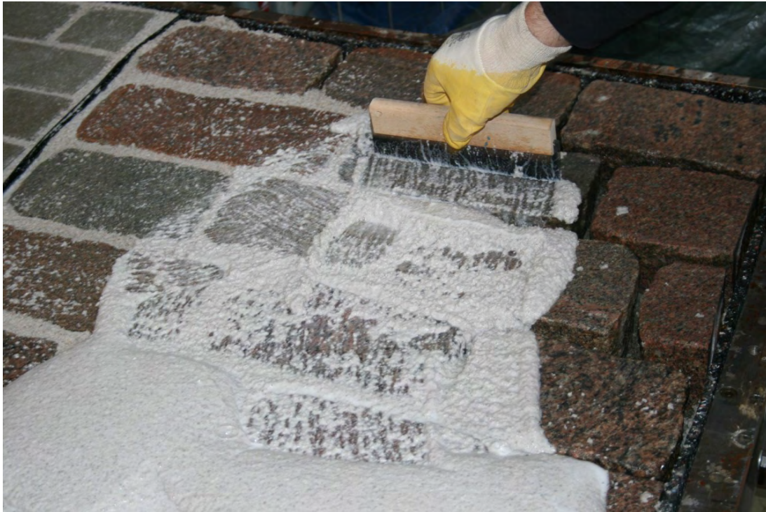
Bild 15: Ausbringen des Kunstharz-Pflasterfugenmörtels ROMPOX D2000 auf der Prüffläche „Natursteinpflaster“.
