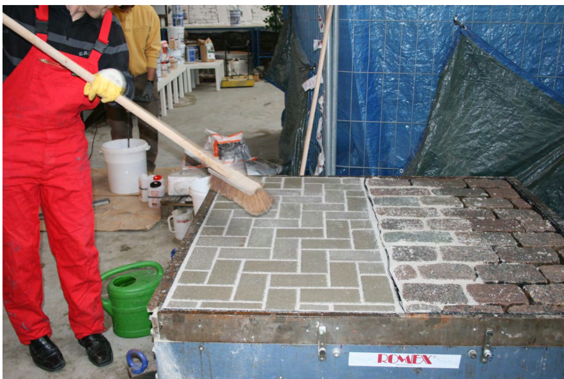
Bild 14: Endreinigung mit einem feinen Besen.
