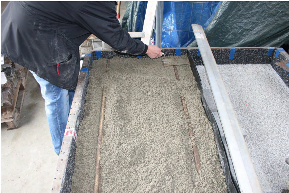
Bild 6: Einbringen des Bettungsmörtels (ROMEX-TRASS-BETTUNG) für die Teilfläche „Betonsteinpflaster“.
