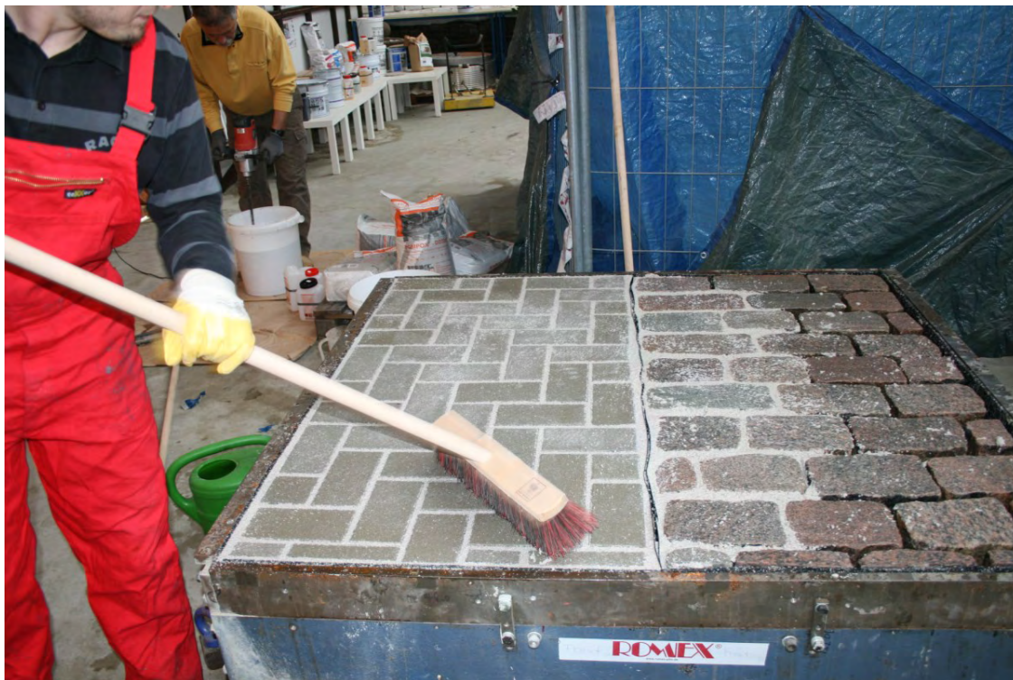
Bild 13: Reinigung der Oberfläche „Betonsteinpflaster“ mit einem groben Straßenbesen.
