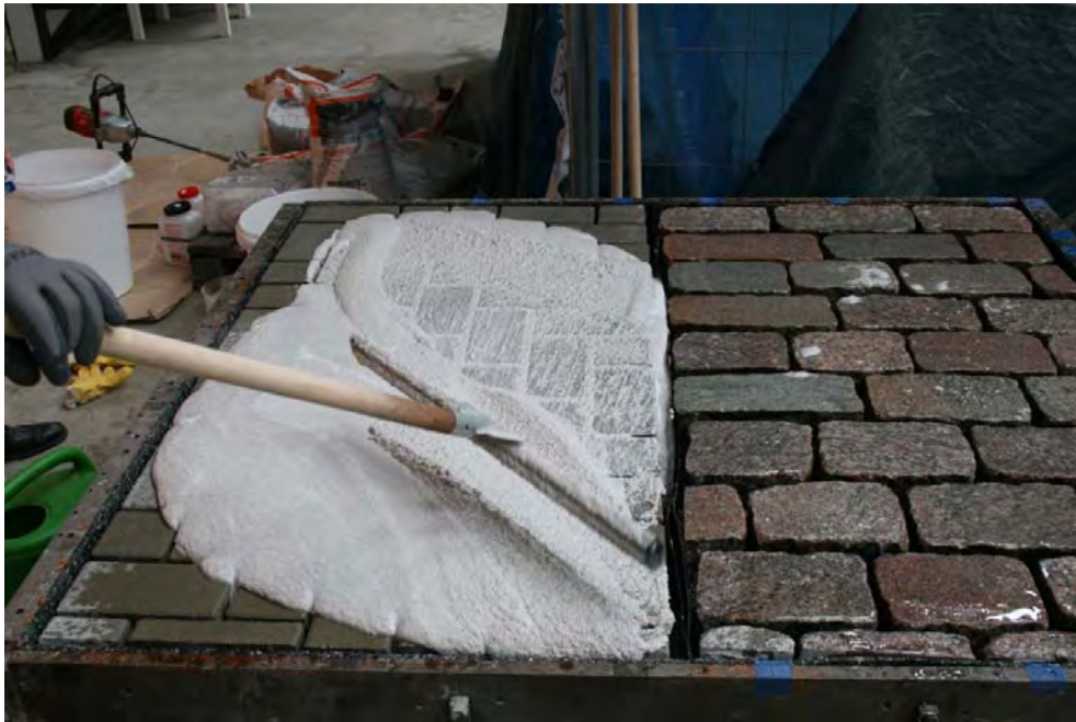
Bild 11: Ausbringung des Kunstharz-Pflasterfugenmörtels ROMPOX D2000 auf der Prüffläche „Betonsteinpflaster“.
