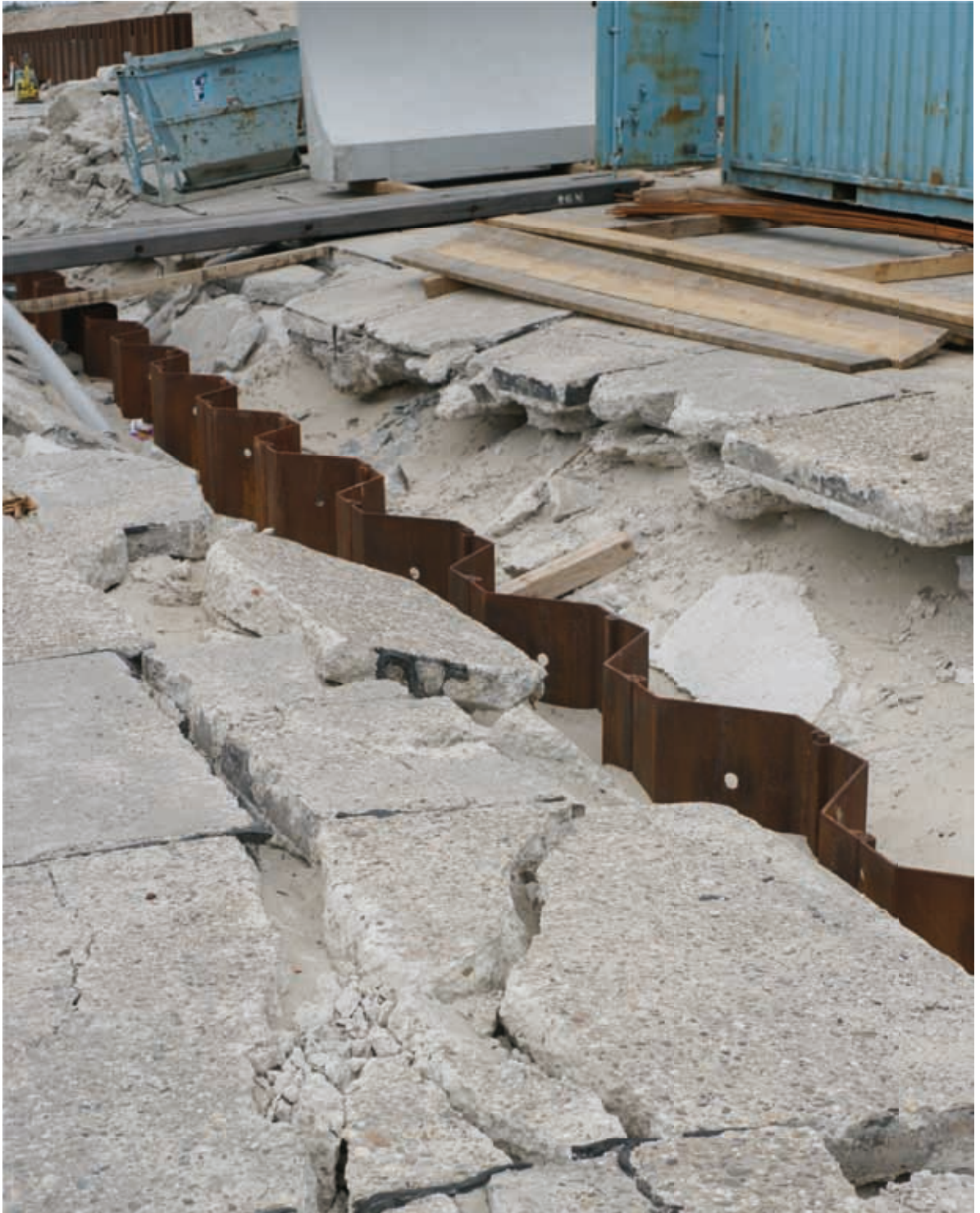
Die alte Wandelbahn wird ausgebaut.
