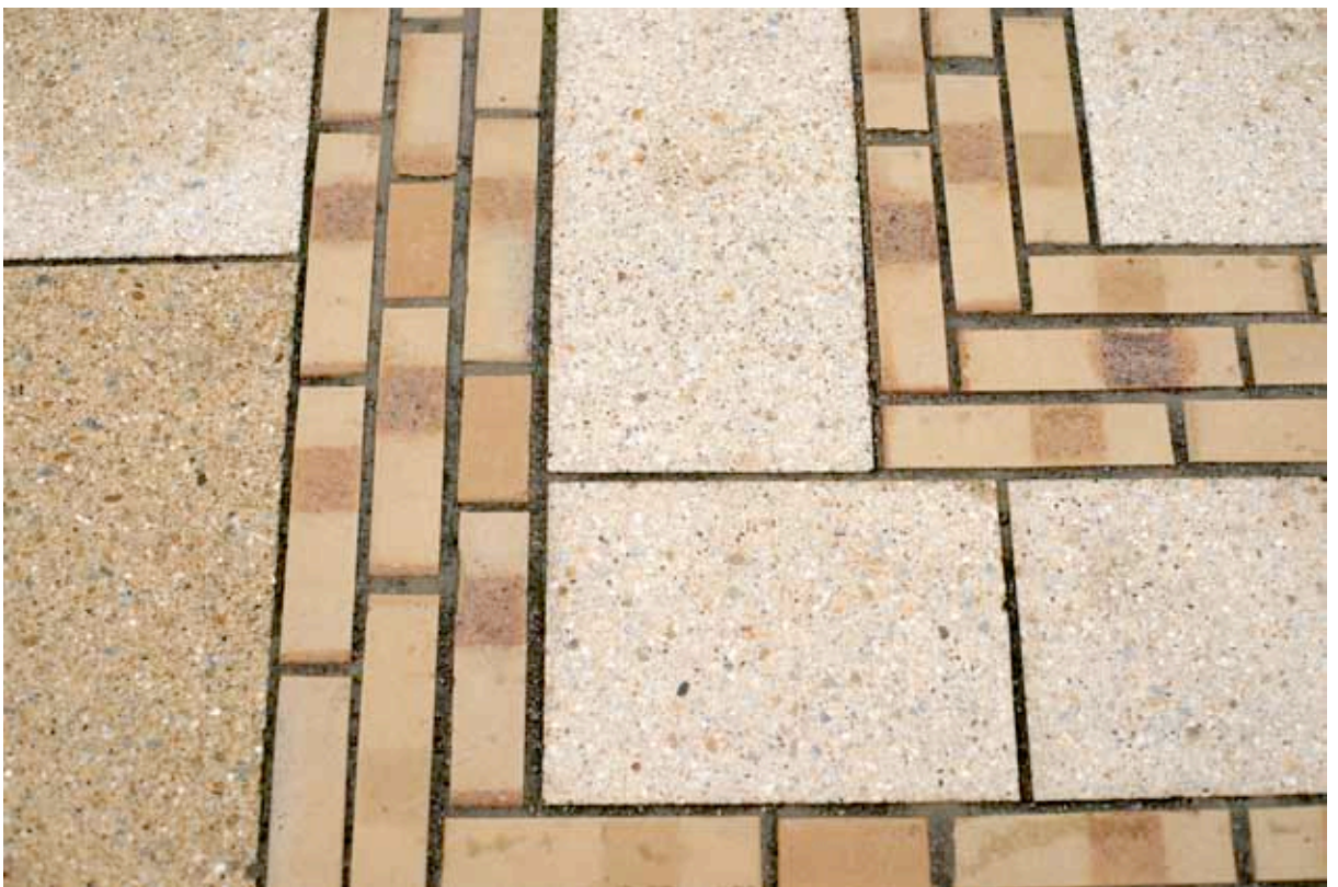
Platten Mit Romex verfugt, die Klinker hingegen mit hydraulisch - gebundenem Fugenmaterial
