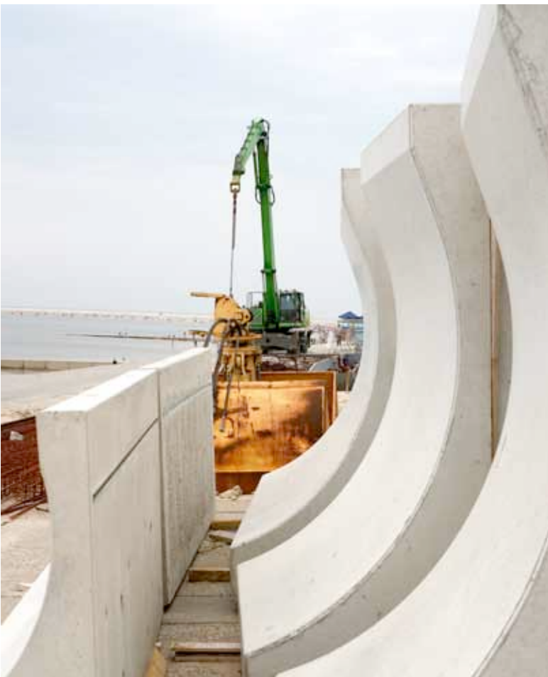
Mannshohe Wellenbrecher schützen die Anlage auch vor kommenden Naturgewalten.
