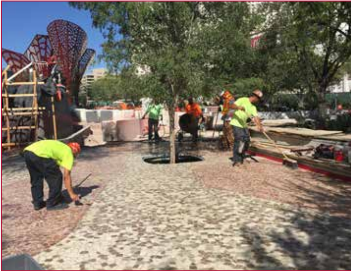
Mischen und Verfugen | Mixing and grouting
