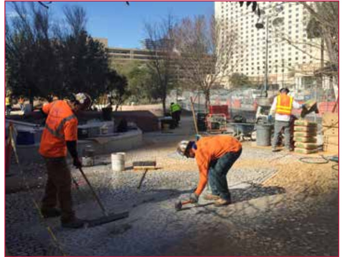
Pflasterverfugung mit ROMPOX® - D2000 | Grouting with ROMPOX® - D2000
